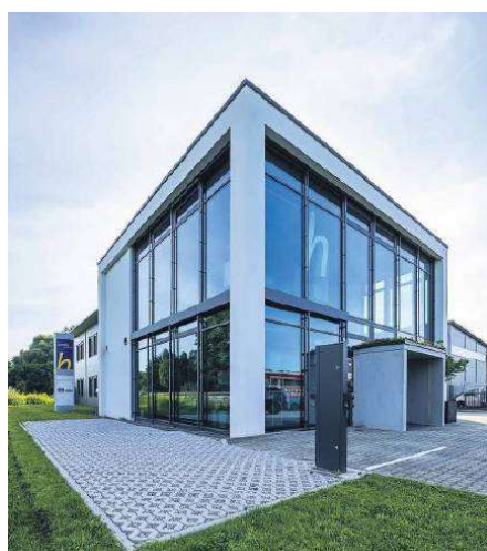
Eine erste Adresse für alles rund um Gebäudetechnik in Hohberg und in der Region FOTOS: HUBER GEBÄUDETECHNIK GMBH & CO. KG
